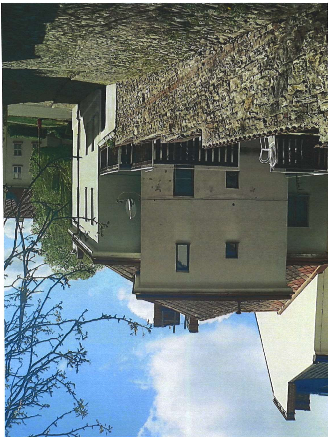
Pohled na posuzovaný objekt rodinného domu č.p. 214/5 od západu s dvorním přístavkem domu a s ohradní kamennou zdí zahrady včetně detailu kamenného dláždění uličky pro pěší
