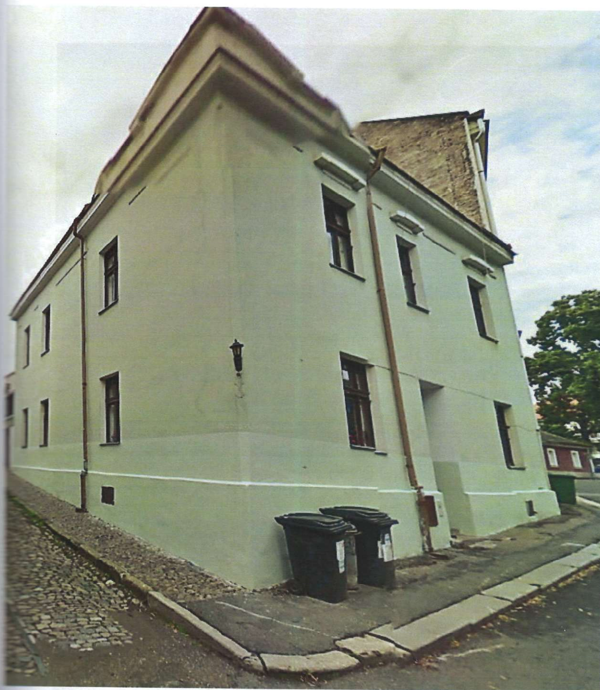
Pohled na posuzovaný objekt rodinného domu č.p. 214/5 od jihovýchodu se vstupem do domu uprostřed východní obvodové stěny domu
