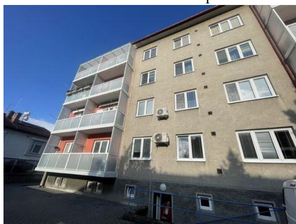
Pohled dvorní - zprava
