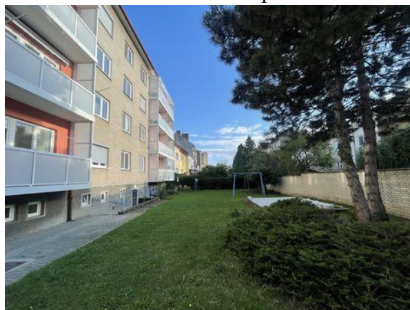
Pohled dvorní na pozemek p.č.St.4342/3, pohled č.2
