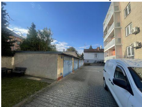
Pohled dvorní na pozemek p.č.St.4342/3, pohled č.1
